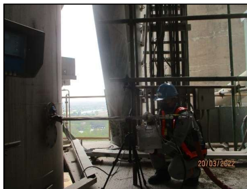
ภาพที่ 3.16 การตรวจวัด NO x as NO 2 จากปล่องหม้อเผา
