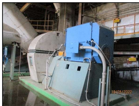
การติดตั้งอุปกรณ์ลดเสียง ที่บริเวณ Cooler
