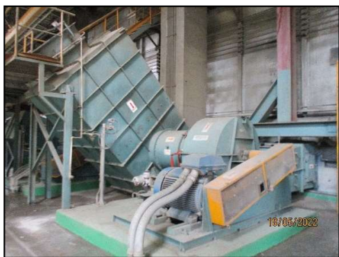
การติดตั้งอุปกรณ์ลดเสียง ที่บริเวณ Cooler
